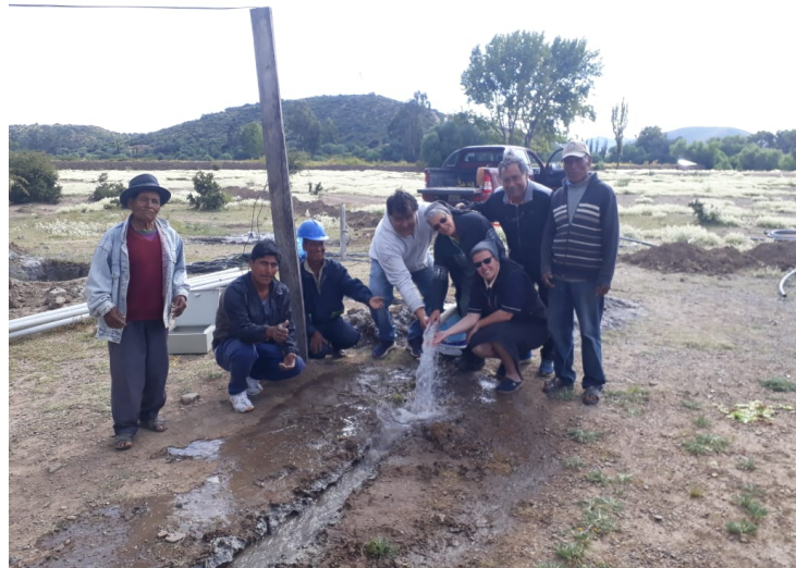
POZZO IN BOLIVIA – VILLACAYA
